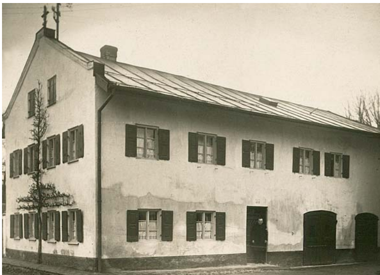
Buchbach mittels Dachreiter von Haus zu Haus gezogen
